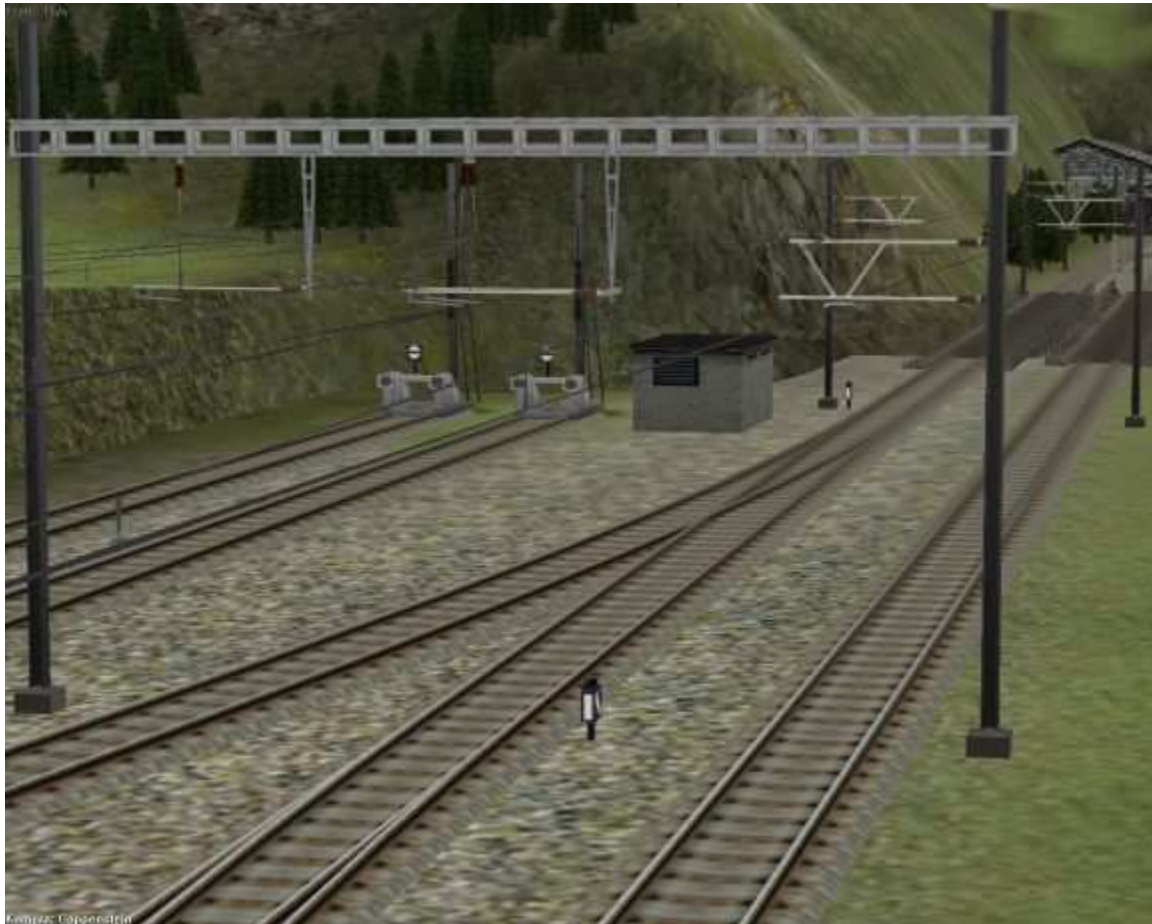
Quertragwerk und Endmasten
